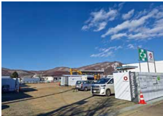
仮称「業務スーパー藤野店」の建設現場
