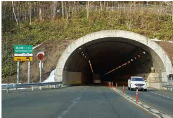
4車線化に着手する東占冠トンネル
