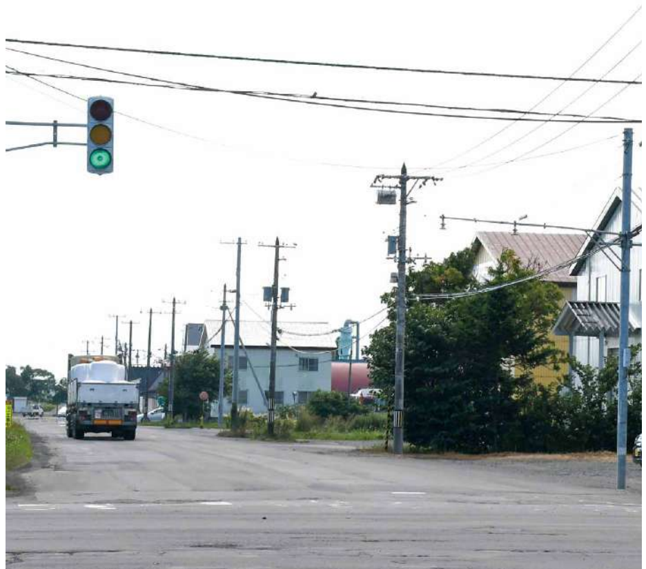
幅約8mの現道がある南工区の終点付近（江別市工栄町）
