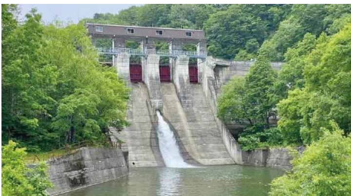
雨竜第二ダム
