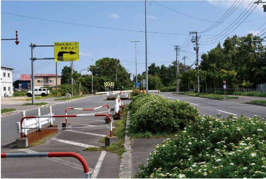
北工区の起点付近までは茨戸福移通として整備済み（東区中沼町）
