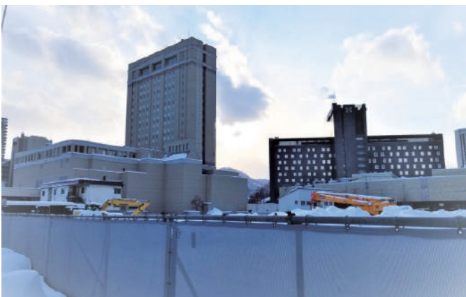
旧ヤマハ札幌ビル跡地で着工する仮称「AXA札幌PJ」
