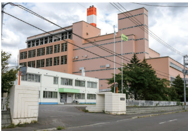
移転予定の西清掃事務所（写真手前）と更新を計画する発寒清掃工場（同奥）
