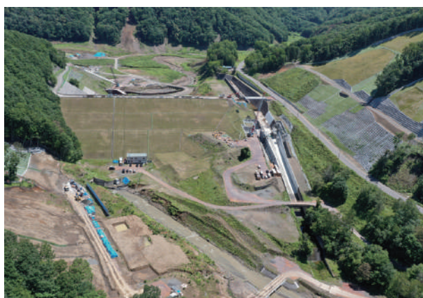
復旧が進む厚真ダム（2022年8月）
