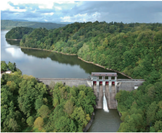
嵩上げ工事に着工する雨竜第二ダム
