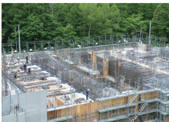
補助金を活用した施設整備の工期延長や繰越制度活用を要望しました
