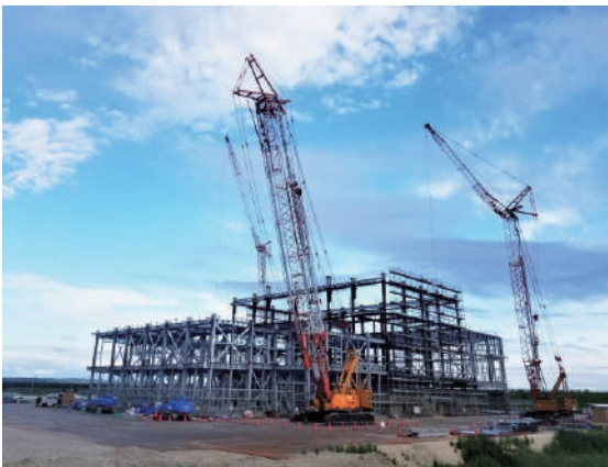
道央廃棄物処理組合が進めている焼却施設建設工事
