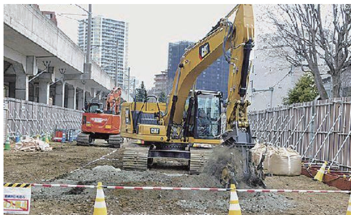
札幌トンネル桑園工区では地盤改良工に着手しました
