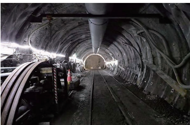
掘削が進む大沼トンネル避難坑
