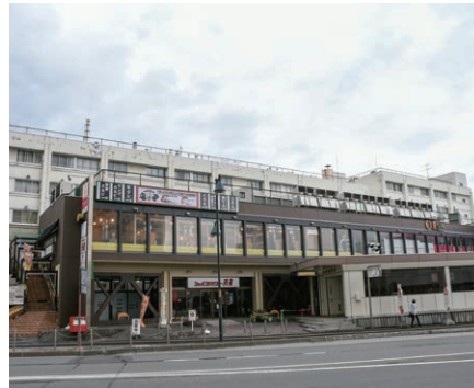
1、2階の店舗を営業したまま3階以上の改修を検討する光星団地5号棟
