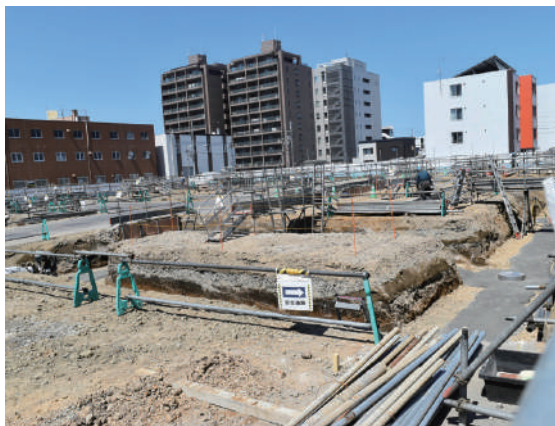
10月オープンに向け工事が進む
